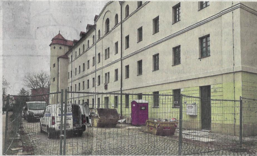
Die Sanierungsarbeiten am Haus Mechthild in Schönebeck sind seit Monaten abgeschlossen. Dennoch können keine Bewohner einziehen, ARCHIVFOTO: STEFAN DEMPS
